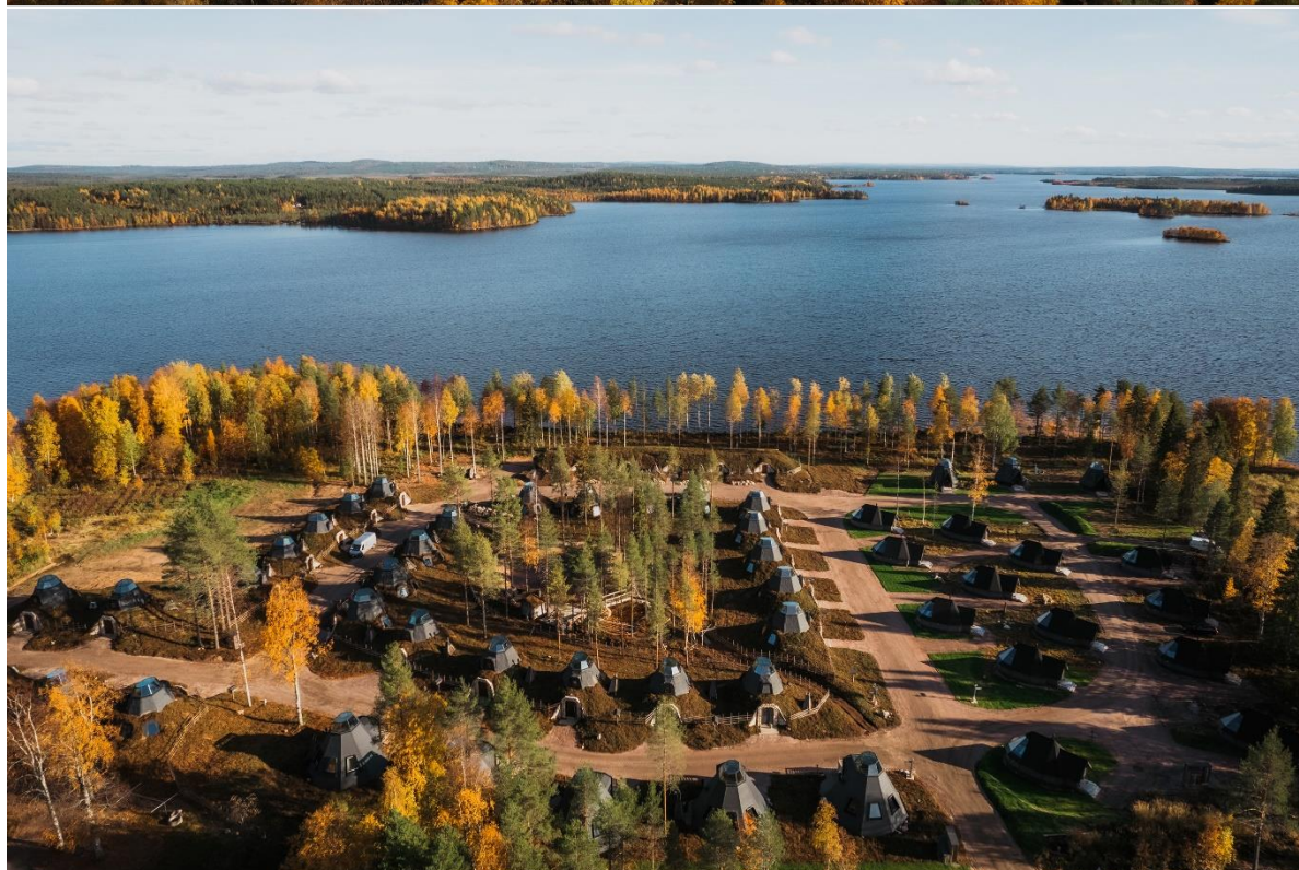
Kuva 7. Apukka Resortin rakennuksia VT 4 suunnalta.
